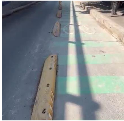
Confinadores prefabricados o “quesadillas” ubicadas en Calzada de Tlalpan a la altura de División del Norte en sentido sur.
